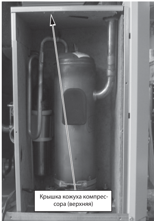
4. Снимите крышку кожуха компрессора (верхнюю).
